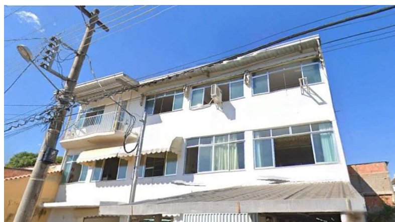
Figura 8 – Edifício adaptado para confecção de bairro
