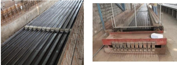
Figura 2 – Pista de protensão com detalhe da cabeceira ativa
