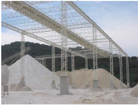
Figura 1 – Sistema estrutural em forma de treliça. Fonte: Seçer (2009)
