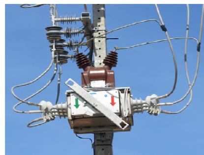
Instalou-se, também, um conjunto de sensores de tensão e corrente responsável por captar os sinais analógicos da rede. O RGDAT é responsável por toda a lógica que controla o comando da chave motorizada. Na Figura 6 é ilustrada a instalação do sensor deste sistema.
