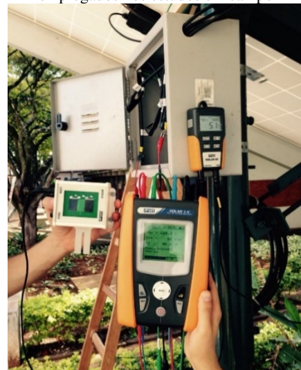
Figura 8 – Equipamento Solar IV 400 da HT Instruments empregados nos estudos em campo
