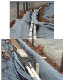
Figura 2b – Efeito da umidade na trincheira de infiltração
