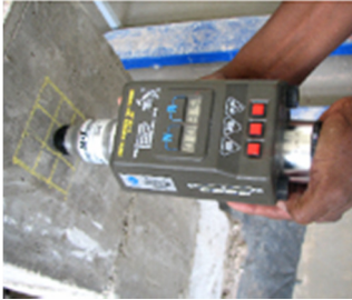
Figura 8 – Utilização do equipamento para obtenção do índice esclerométrico
