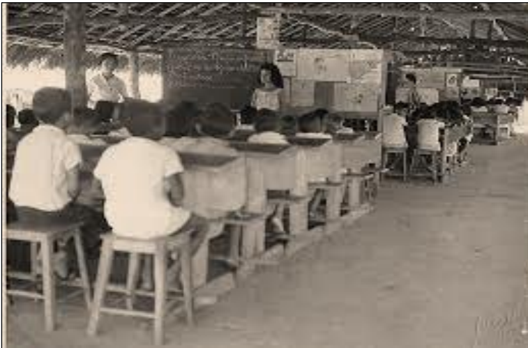
Figura 3 – Construção do primeiro acampamento do bairro das Rocas
