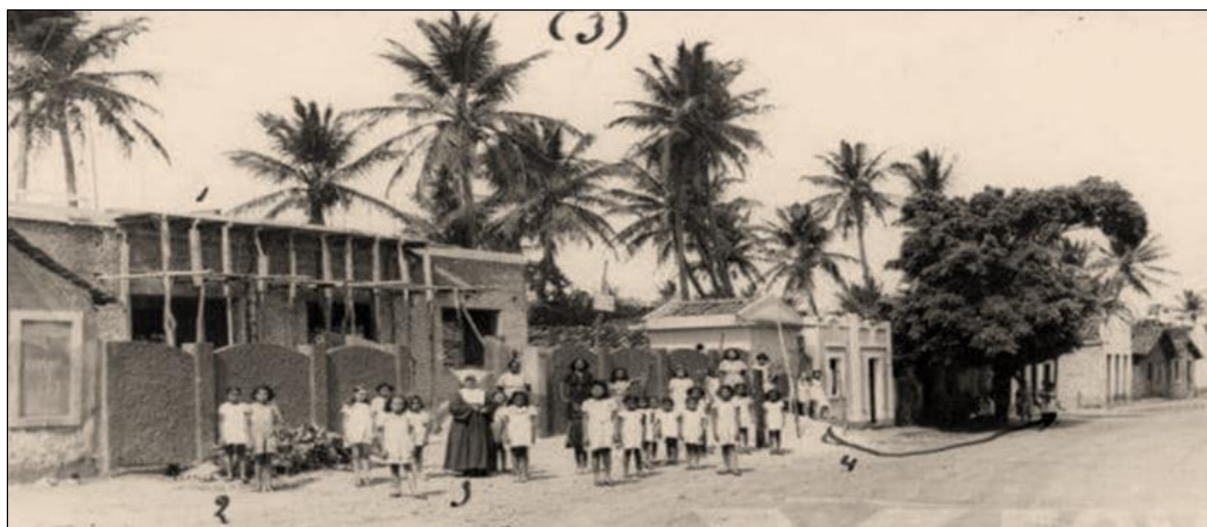
Figura 1 - Início da construção da Escola e Laboratório São José, liderada pela Irmã Vitória, nas Rocas
