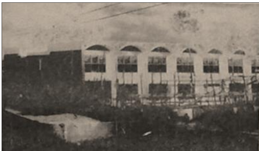
Foto 2: Fachada do prédio da ENECG
