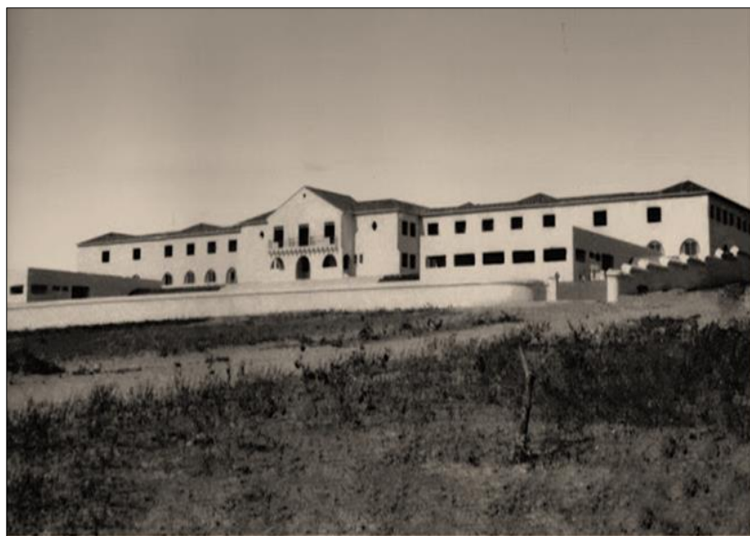
Foto 1: Fachada do prédio do Estadual da Prata
