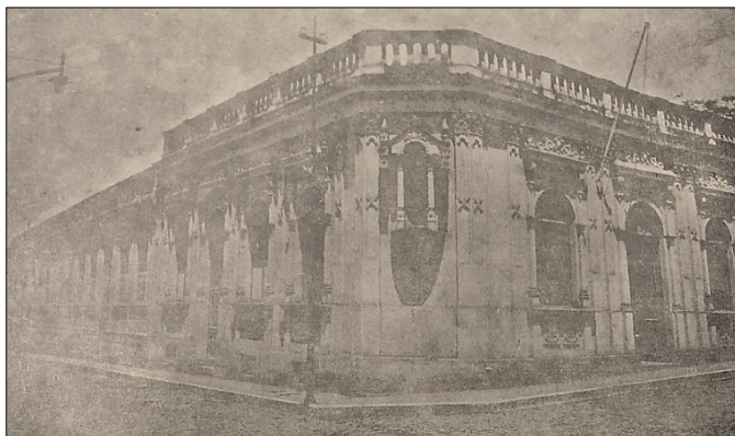
Figura 3 – Edifício da Escola Normal
