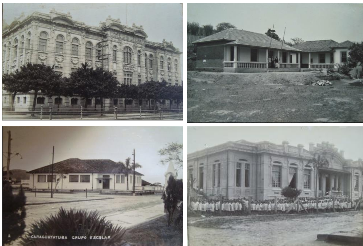
Figura 9 – Fachadas de prédios de grupos escolares da região escolar de Santos. 15
