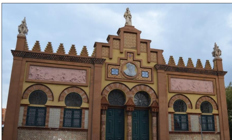
Fig. 5 - Aspeto da fachada da “Creche Emília Jesus Costa e Asilo António Almeida da Costa”.
