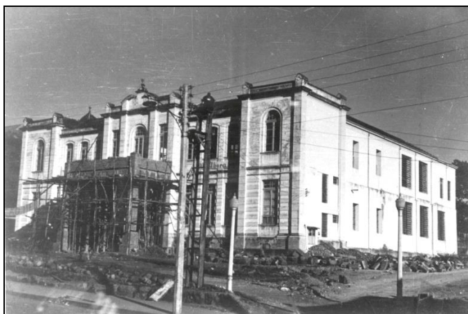
Figura 1 - Obras de reforma do prédio da FMTM em [1960]
