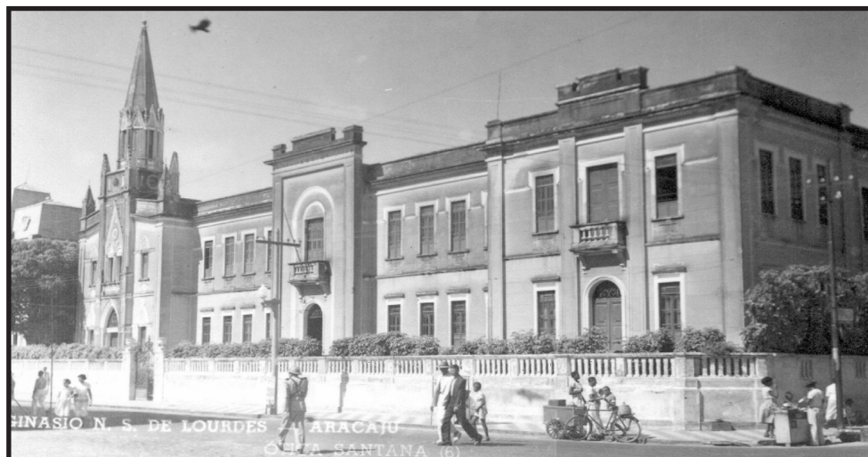
FIGURA 1 - Fachada da Capela e do Colégio Nossa Senhora de Lourdes. Aracaju, década de 1940.
