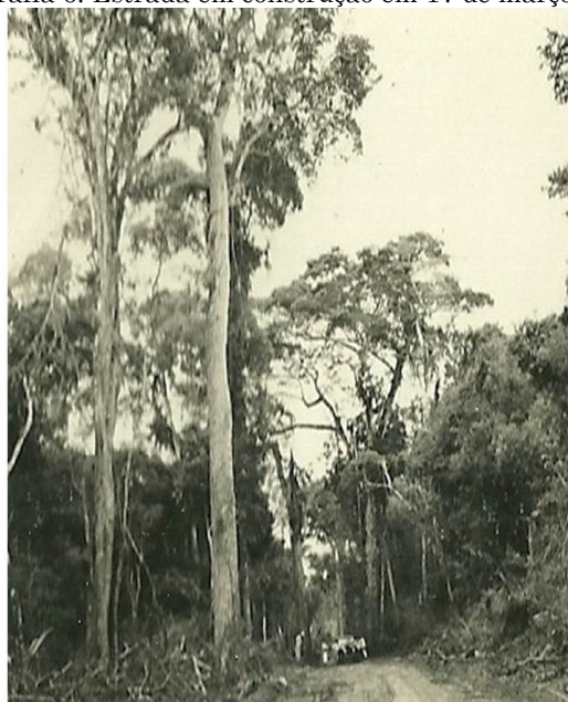
Fotografia 6: Estrada em construção em 17 de março de 1953.
