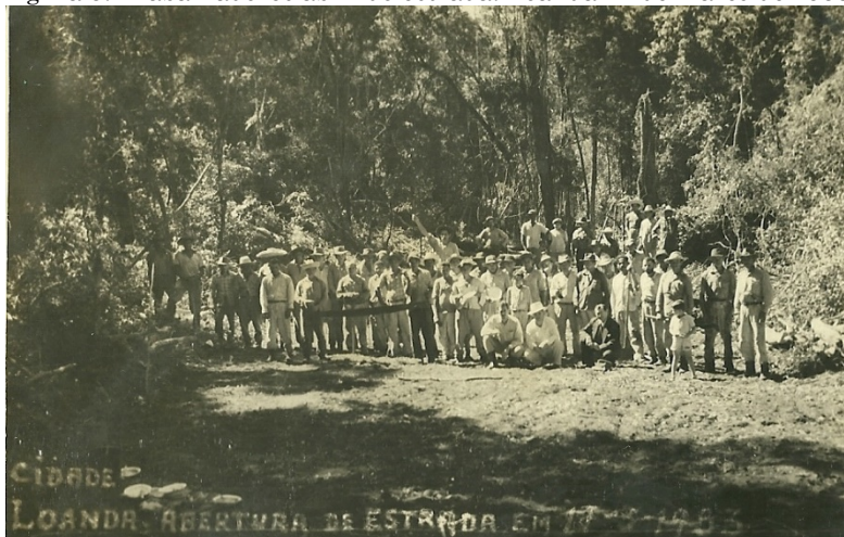
Figura 9: Trabalhadores abrindo estrada. Loanda 11 de março de 1953.
