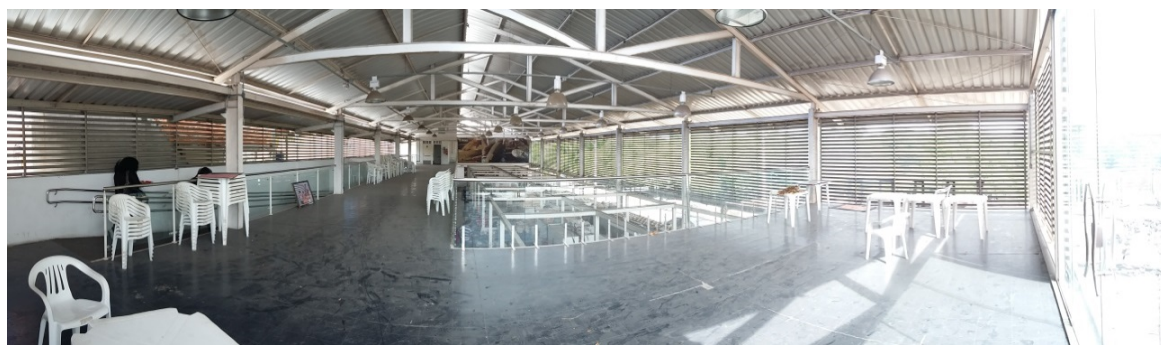
Imagem 19 – Vista panorâmica do mezanino, atualmente sem utilização.
