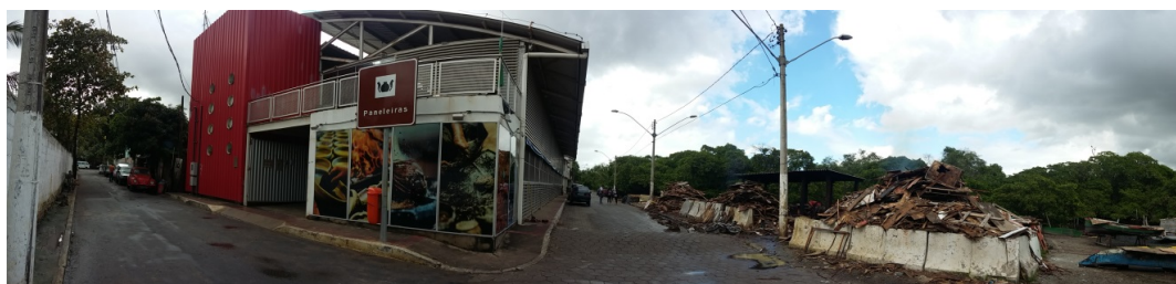
Imagem 13 – Vista Panorâmica a partir da esquina da Rua das Panelleiras com a Rua João Gomes Lorêto onde está localizado o Galpão da Associação da Panelleiras de Goiabeiras. Junto ao manguezal à direita, ao fundo, está o local de estocagem de madeira, queima e açoite das panelas de barro. Autoria: Simone Campos Pires Fonte: INRC Panelleiras de Goiabeiras (2016).
