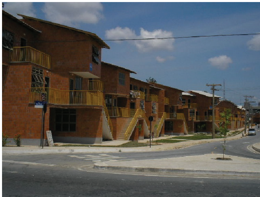
Figura 09: Visão geral das unidades habitacionais do PROSAMIM no bairro do Centro. Fonte: Waldemir Costa Júnior, 2007.
