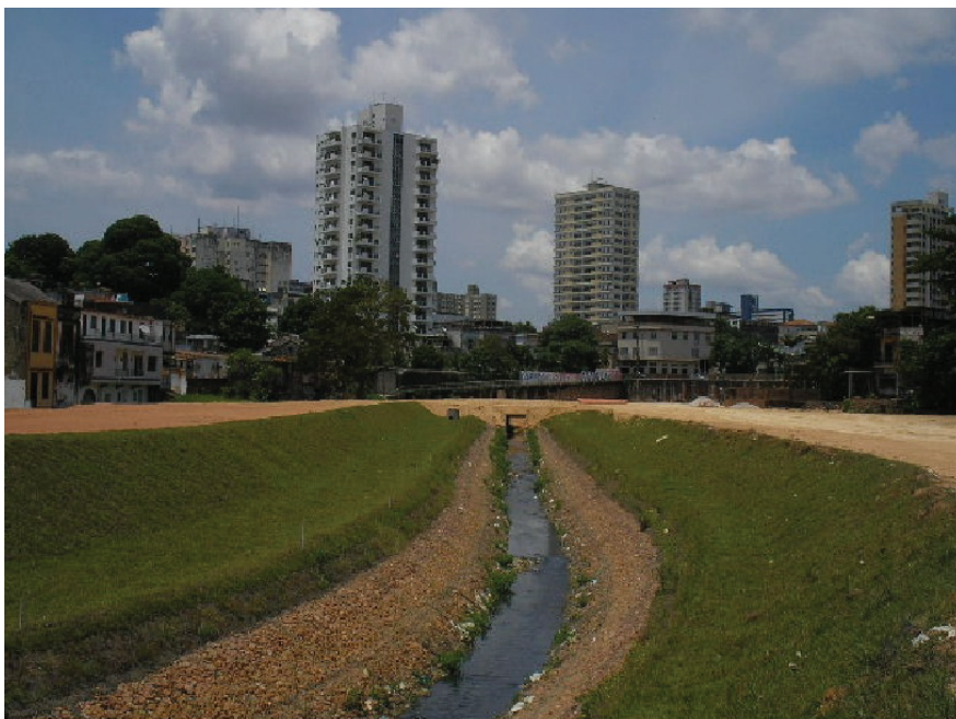
Figura 06: Trecho do igarapé de Manaus (Centro) canalizado e com margens aterradas/compactadas entre a Avenida 7 de Setembro e igarapé Bittencourt. Fonte: Waldemir Costa Júnior, 2007.
