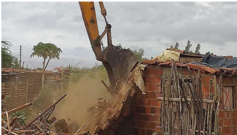
Figura 02- Máquina utilizada durante a derrubada na ação de despejo no assentamento Irmã Dorothy, em 2019
