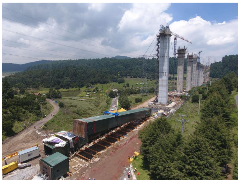
Figura 2: Construcción del Tren Interurbano México-Toluca.
