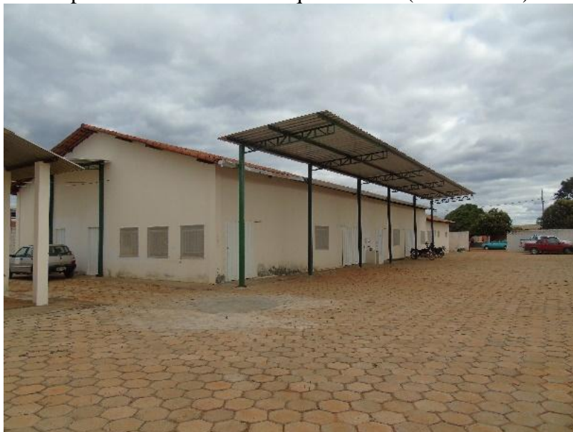
Foto 10: Imóvel onde funciona o entreposto do mel gerido pela Associação dos Apicultores do Vale do Jequitinhonha (AAPIVAJE)
