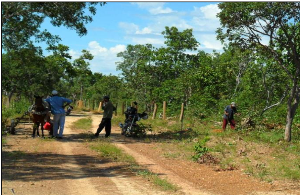
Figura 2 - Construção da cerca de um sítio na comunidade Angical
