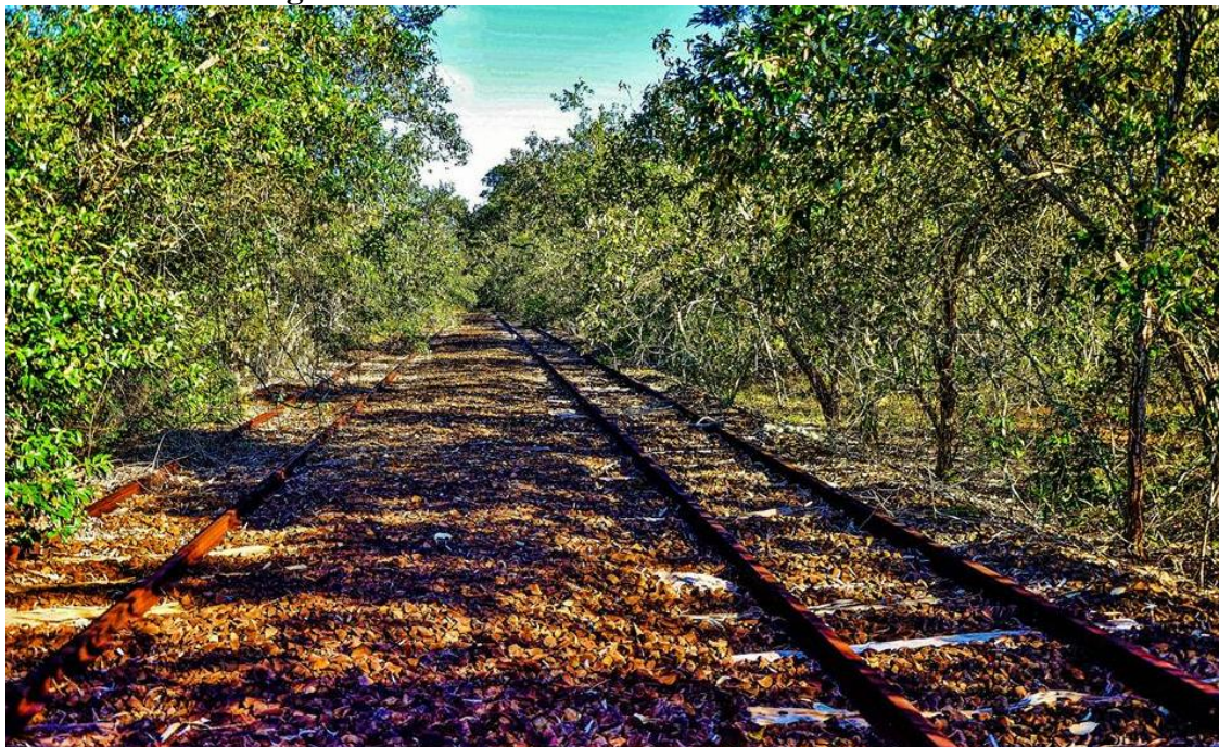
Figura 07. Trilhos da Ferrovia nas áreas do PEMD.
