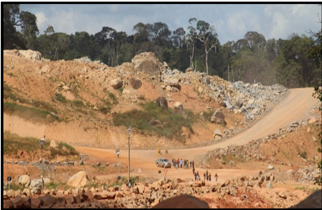
Figura 12: Construção da ponte no Km 50 3 .
