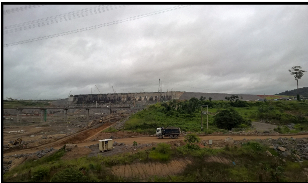
Figura 13: Canal de fuga localizado no km 52 (Vila Santo Antônio).
