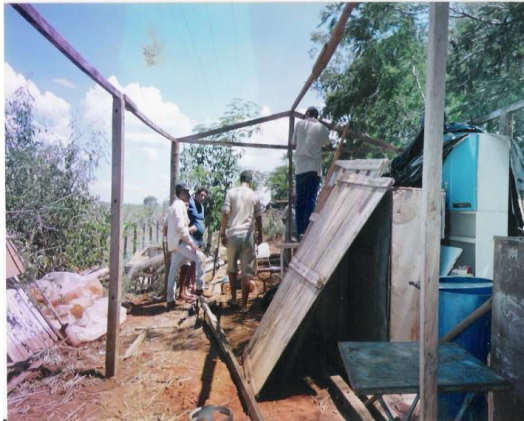
Foto 3-Montagem dos barracos. Fonte - Arquivo, Assentados 2000
