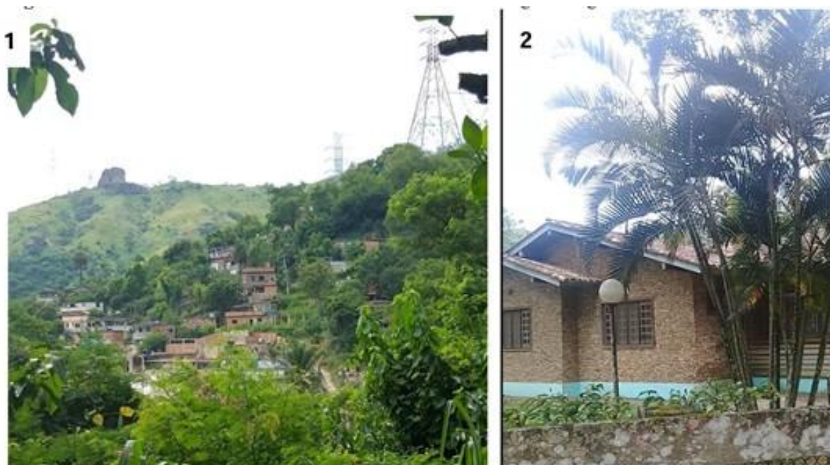
Figura 2 - Padrão construtivo das residências nas RAs de Realengo e Vargem Grande
