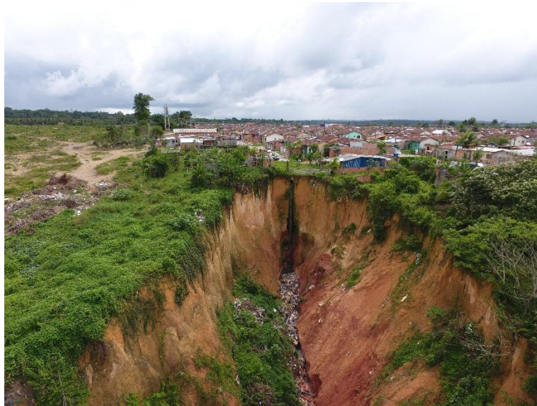
Figura 5 - Vista parcial da voçoroca em Rio Preto da Eva (AM)
