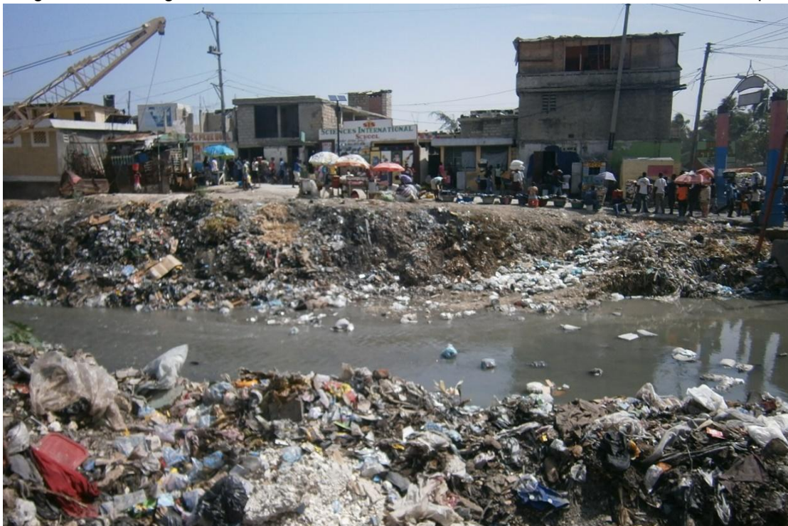
Figura 4 - Descarga direta de resíduos sólidos na ravina de Bois-de-Chêne, Porto Príncipe
