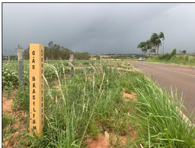
Figura 4 - Marco de sinalização do gasoduto da Necta, localizado às margens da estrada vicinal que liga Narandiba a Pirapozinho (SP)
