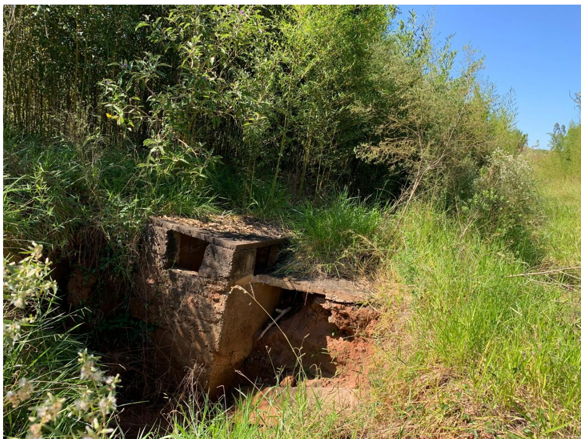
Figura 12 - Captação de águas pluviais da Rodovia SP-147 lançando-as na cabeceira da voçoroca
