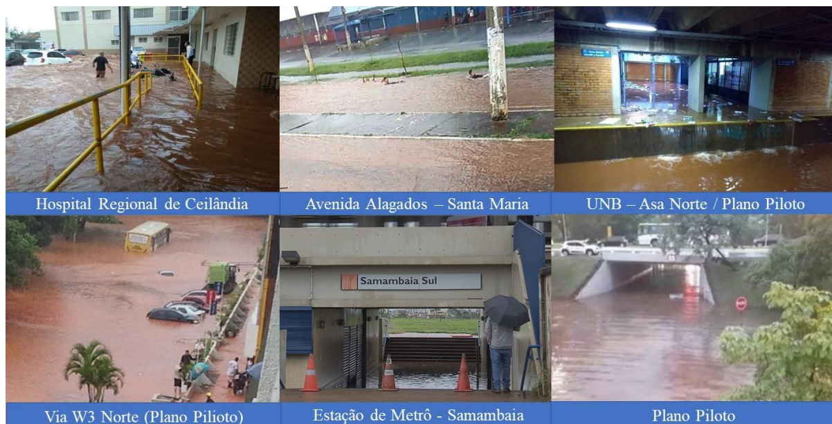
Figura 17 - Exemplos de diversos locais alagados no Distrito Federal em diferentes anos
