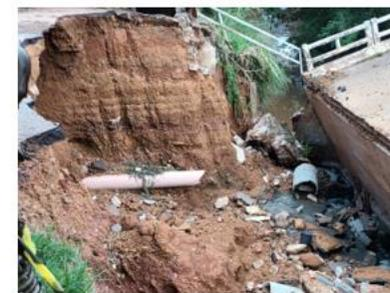
Lançamento de esgoto por consequência do desabamento da ponte. P12.
