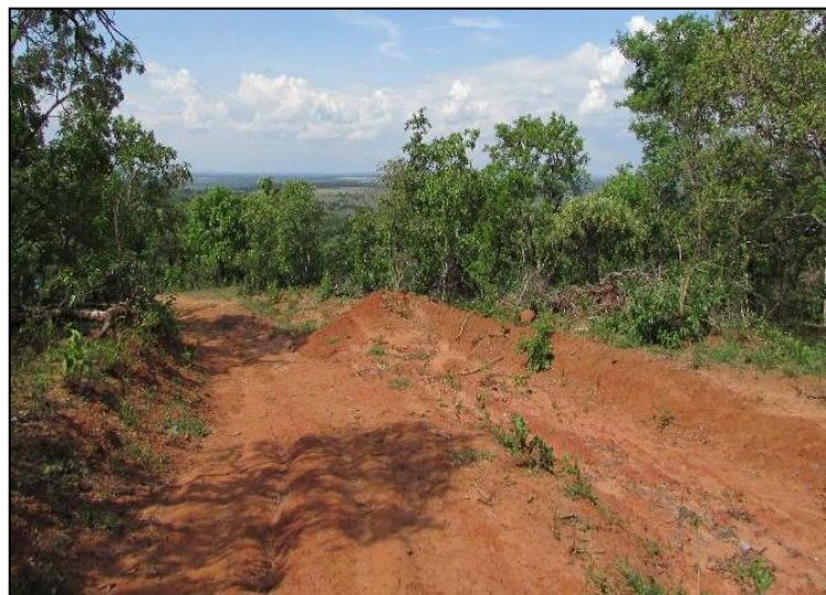
Figura 7 - Vertente regolítica (solos avermelhados) associada a rampa de colúvio, local onde ocorreu a abertura de uma estrada
