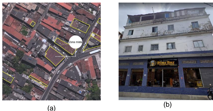
Figura 10 - Exemplificação da classificação Zona Mista: (a) visualização da ortofoto e (b) identificação da edificação e de seus usos via Street View
