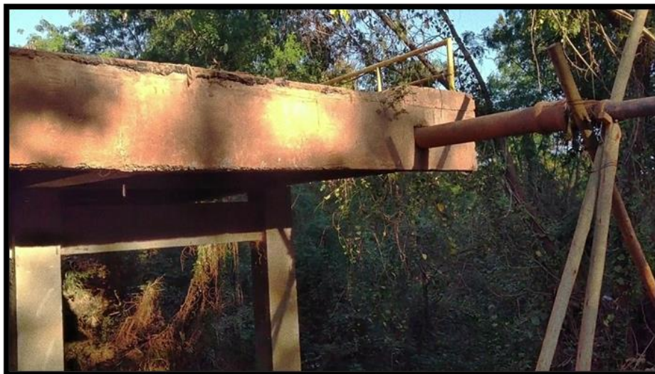
Figura 9 - Bairro Morada do Sol/Montes Claros: Ponte do Rio Vieira, 2020.
