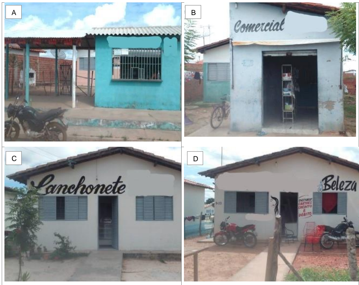
A e B - Estabelecimento de gêneros alimentícios no Conjunto Habitacional São Luiz; C – Lanchonete adaptada em estrutura de UH do Conjunto Habitacional Prefeito César Leal; D – Salão de Beleza adaptado em estrutura de UH no Conjunto Habitacional Prefeito César Leal
