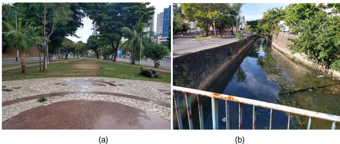
Figura 7 - Trecho tamponado do Rio dos Seixos na Avenida Centenário (Bairro Barra) (a) e Trecho aberto do Rio Lucaia, retificado e emparedado, próximo à foz (Bairro Rio Vermelho) (b).
