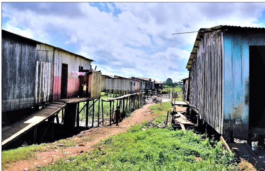
Figura 3 - Casas em palafitas no leito do Igarapé Ambé.
