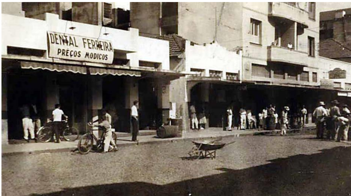
Figura 2 - Uberlândia (MG): asfaltamento da Avenida Afonso Pena: primeira camada de piche, 1956.
