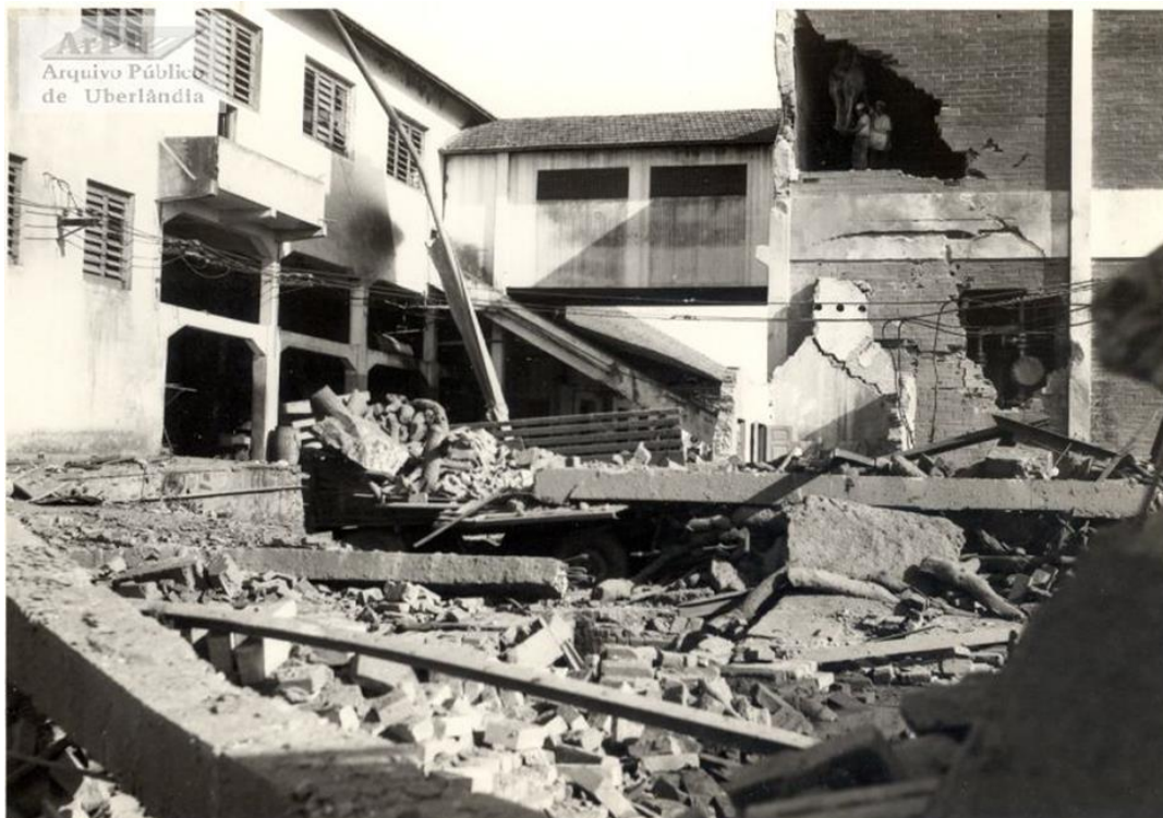
Figura 6 - Uberlândia (MG): demolição da antiga estação da Mogiana, 14 de abril de 1970
