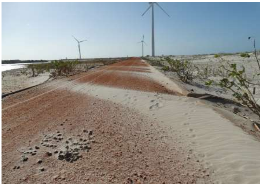
Figura 4 – RDSEPT (RN): Parque eólico em área da RDSEPT com terraplanagem de piçarra e início de deslocamento de dunas, 2017
