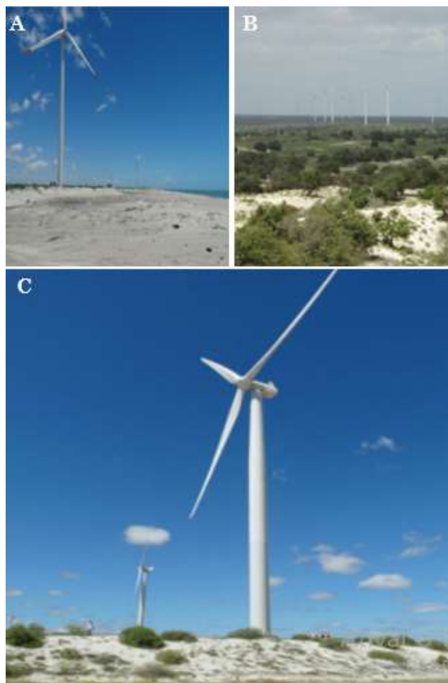
Figura 8 – RDSEPT (RN): (A) Parque eólico de Miassaba II, área de restinga; (B) Parque eólico de Miassaba III, área de tabuleiro; (C) Parque eólico de Alegria II, área de dunas, 2017.
