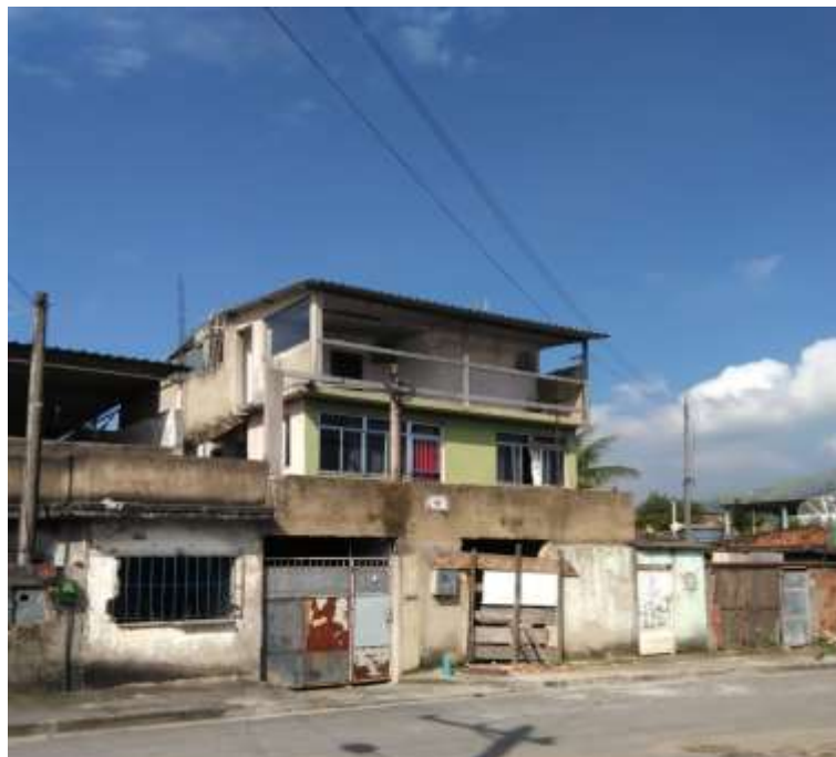
Figura 3 - Nova Iguaçu (RJ): Laje construída (sem a instituição do Direito de Laje) com finalidade de moradia, 2019.
