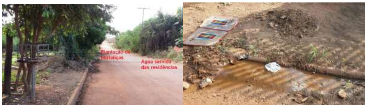
Figura 10 - Águas servidas escoando por rua do bairro Jardim Carlos Gomes Bezerra I (a foto da direita mostra a tubulação irregular coletando essas águas para irrigação).
