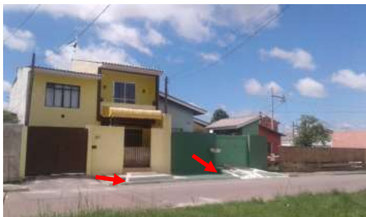
Figura 04 - Descompasso entre a rampa de acesso/escadarias nas casas e a calçada.
