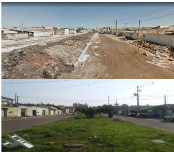
Figura 02 - Afluente do rio Palmital antes e após o manilhamento.
