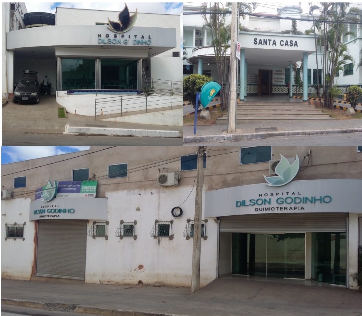
Figura 04 - Fachada das unidades de atendimento oncológico em Montes Claros/MG.
