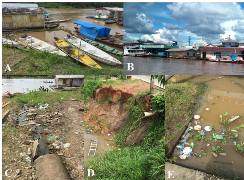
Figura 7 - Quadro de imagens dos flutuantes presentes na orla (A, B), com pontos de presença de esgoto (C), erosão (D) e resíduos sólidos (E), ao longo da orla.
