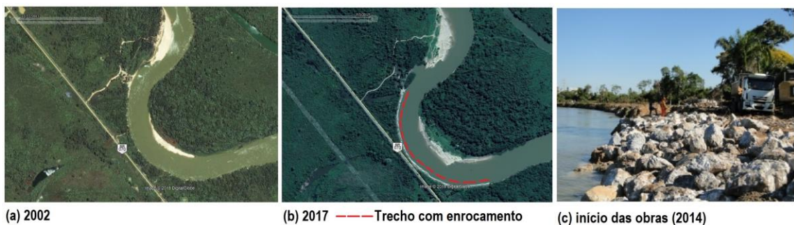
Figura 11 - Erosão marginal em P12 (2002-2017) com instalação de enrocamento no ano de 2014 (b).
