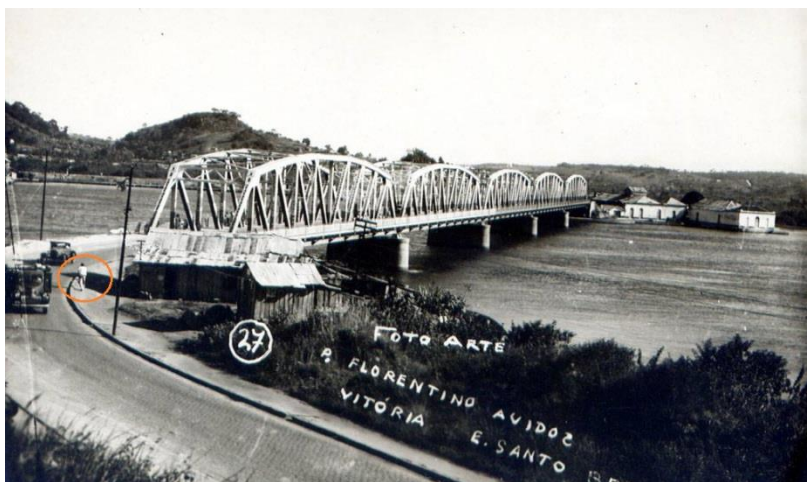
Figura 6 – Ponte Florentino Avidos – em destaque um ciclista.
