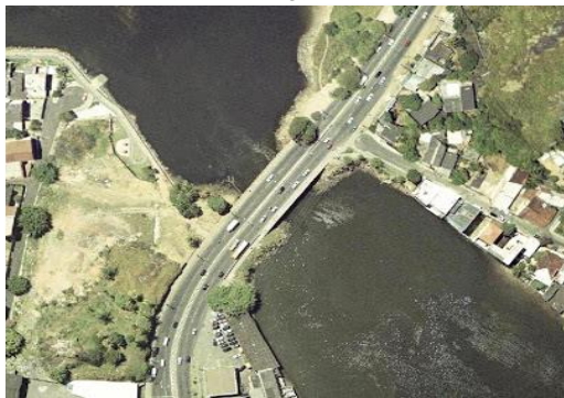
Figura 9 – Ponte da Passagem construída em 1973
