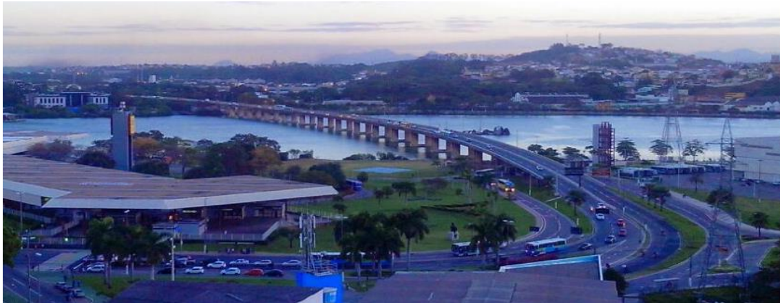
Figura 12 – Ponte Presidente Costa e Silva (Segunda Ponte), 2016
