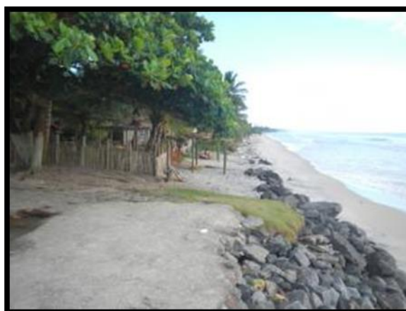
Figura 4 – Alta vulnerabilidade a erosão costeira, praia de São Domingos – trecho 2, Ilhéus.
