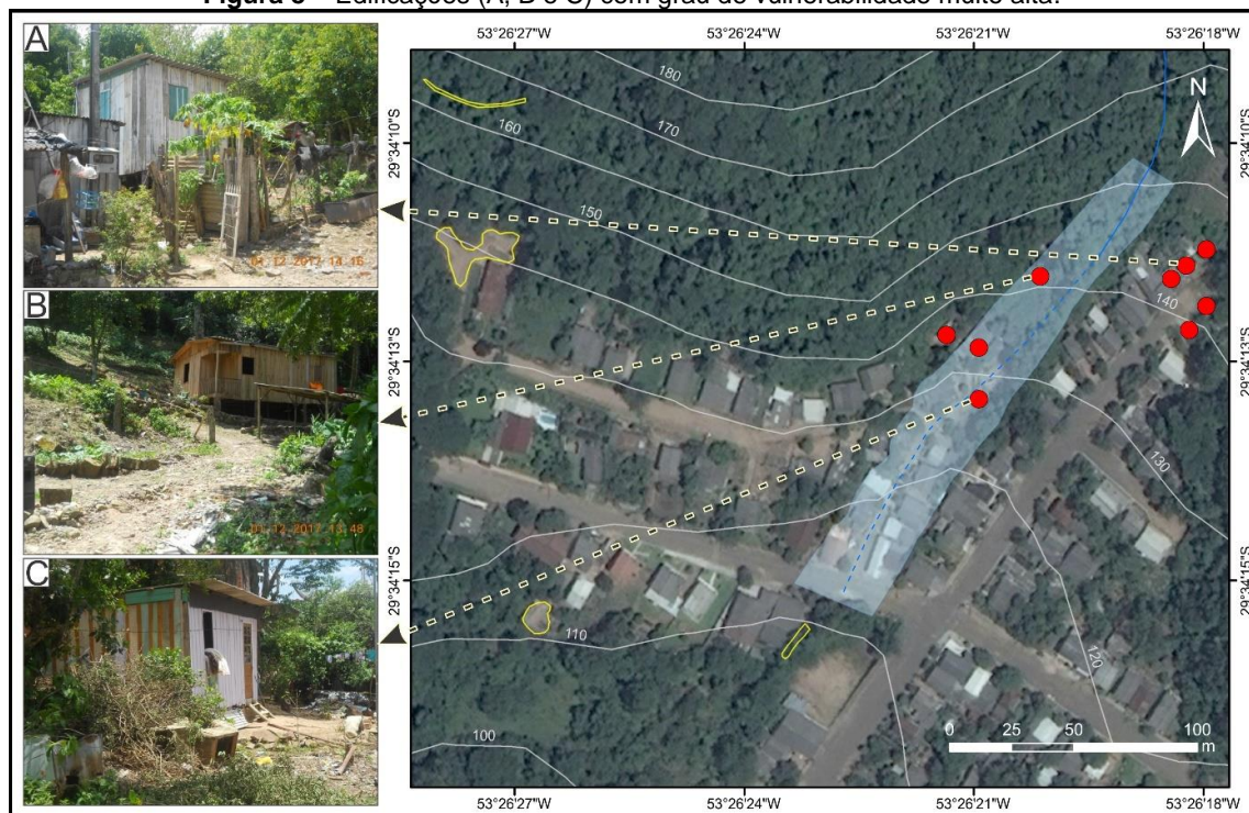
Figura 8 – Edificações (A, B e C) com grau de vulnerabilidade muito alta.
