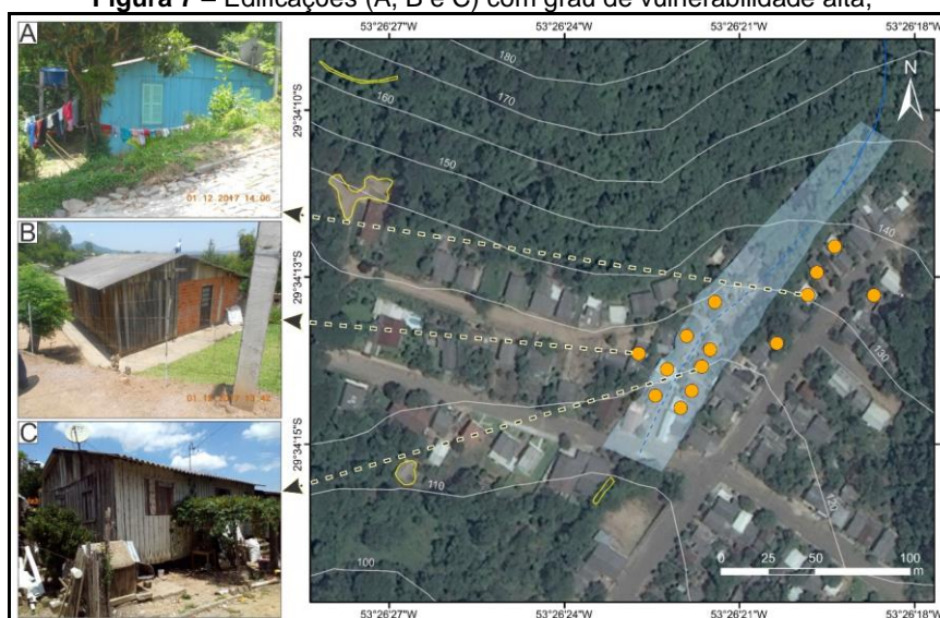
Figura 7 – Edificações (A, B e C) com grau de vulnerabilidade alta,
