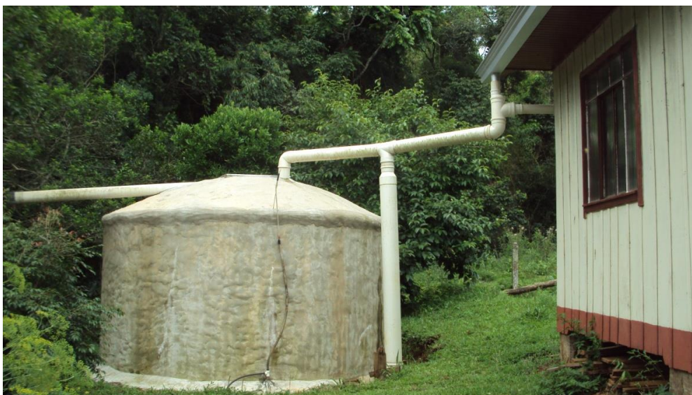
Figura 7 – Cisterna de ferrocimento com capacidade de 33 mil litros de água
