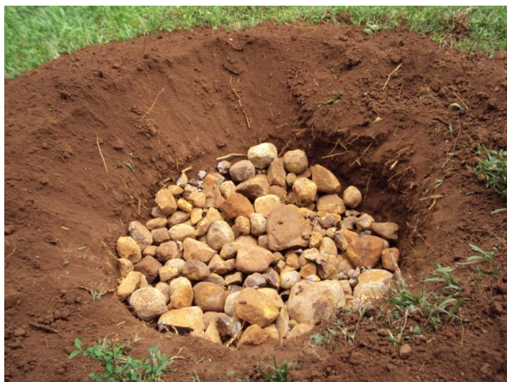
Figura 10 – Círculo de bananeiras em fase de construção
