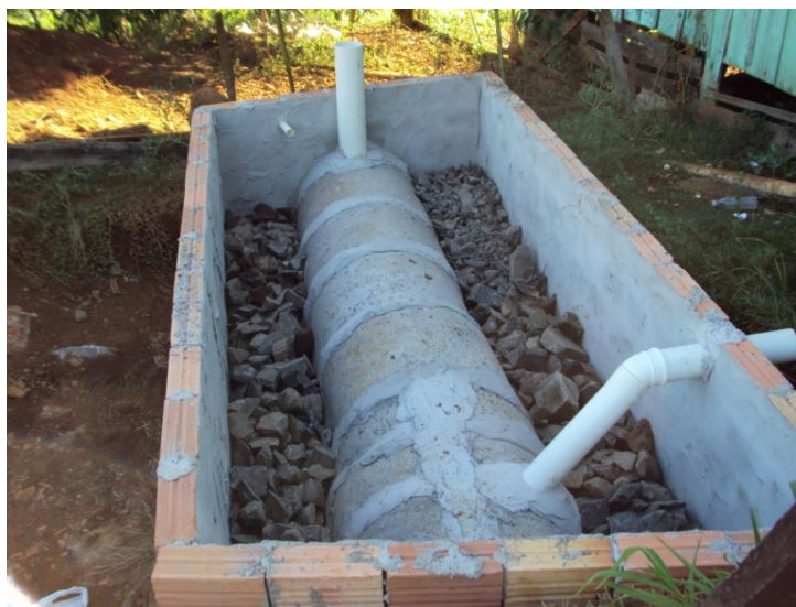
Figura 8 – Fase de construção do canteiro bioesséptico
