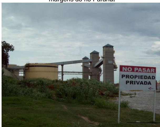
Figura 5. Elevadores do porto agroindustrial de Molinos Rio de La Plata, cidade de San Lorenzo, às margens do rio Paraná.
